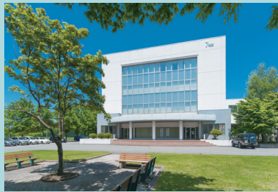
G 7号館／実習棟
